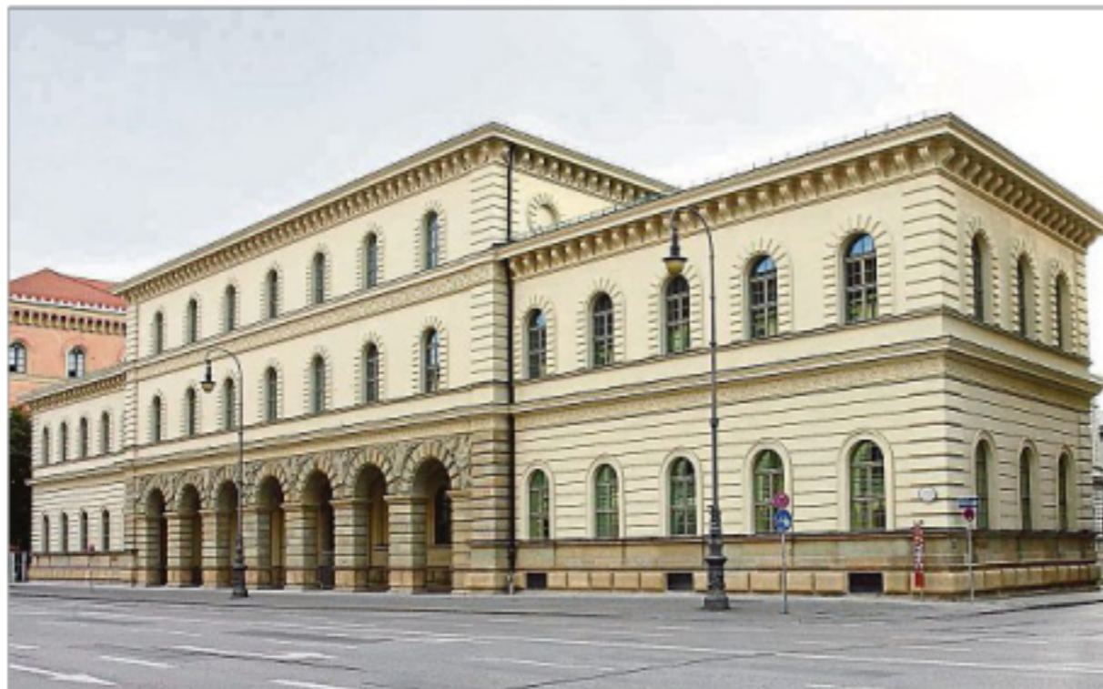
Die sanierte Fassade des Hauptstaatsarchivs an der Ludwigstraße. FOTOS DORIS WÖRNER/BAYERISCHES HAUPTSTAATSARCHIV
