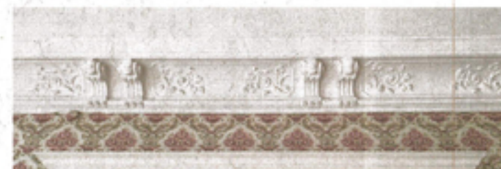
Die Stuckdecken wurden als original befunden und sollen erhalten werden.
