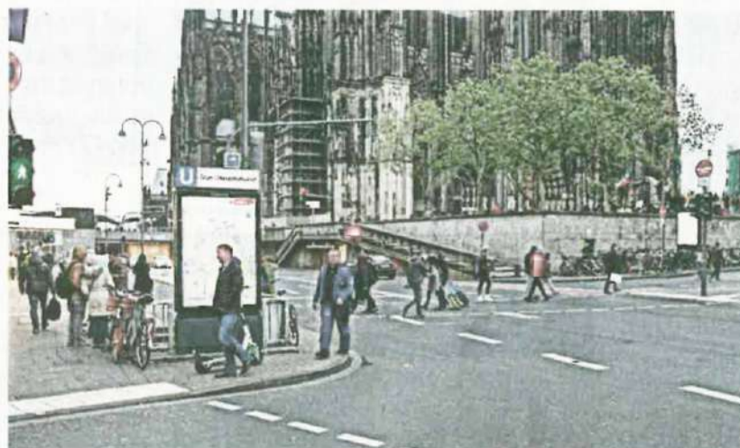
Der U-Bahn-Eingang an der Ecke Trankgasse/Marzellenstraße soll zurückgebaut werden.
