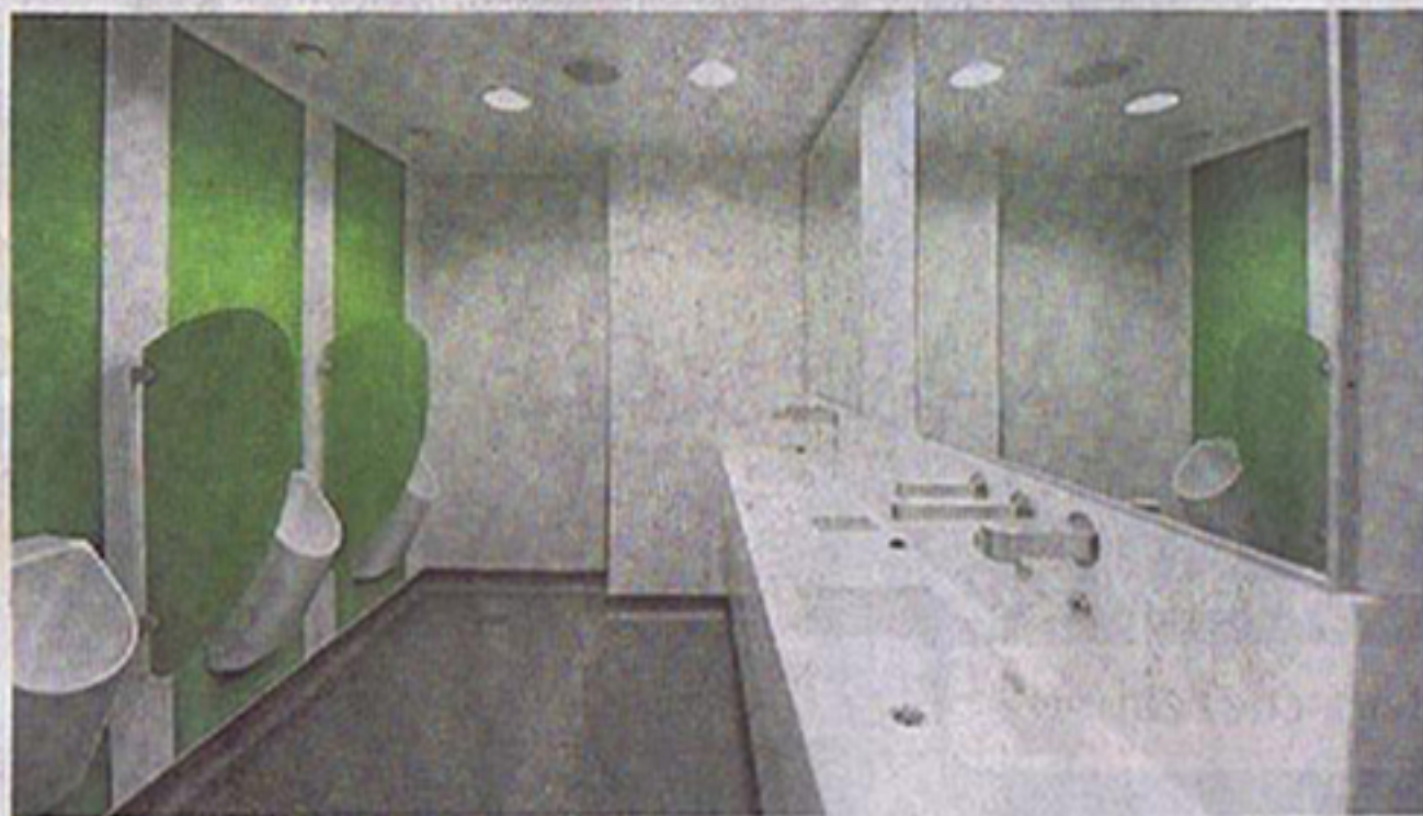
Saubere Angelegenheit: die neue Toilettenanlage an der Freiheit.
